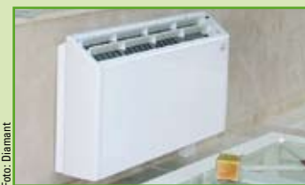
Eine Wärmepumpe reguliert das gesamte Klima eines Wintergartens, indem sie die Funktionen der Kühlung, der Beheizung und auch der Luftreinigung übernimmt.
