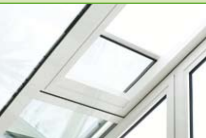
Der Hebe-Schiebe-Lüfter , eine moderne Form der klassischen Entlüftung im Dachbereich.
